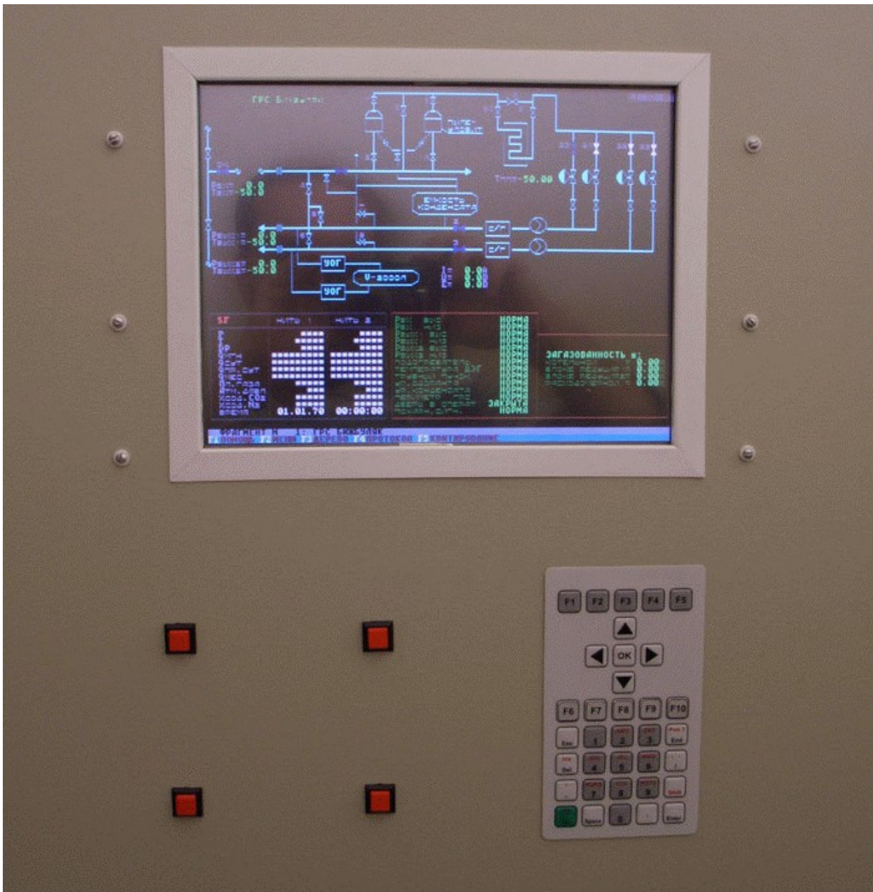
Рис. 1-1. Панельный компьютер смонтированный в дверь шкафа
