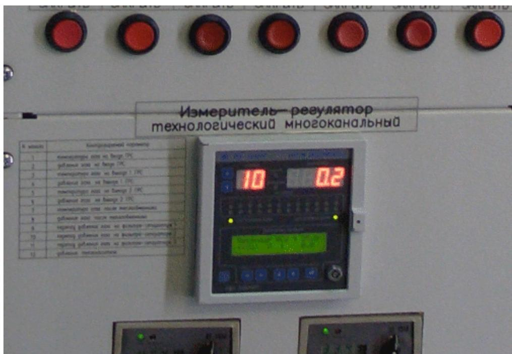
*Рис. 1-1. Передняя панель прибора ИРТМ-2402/МЗЕх-2*
